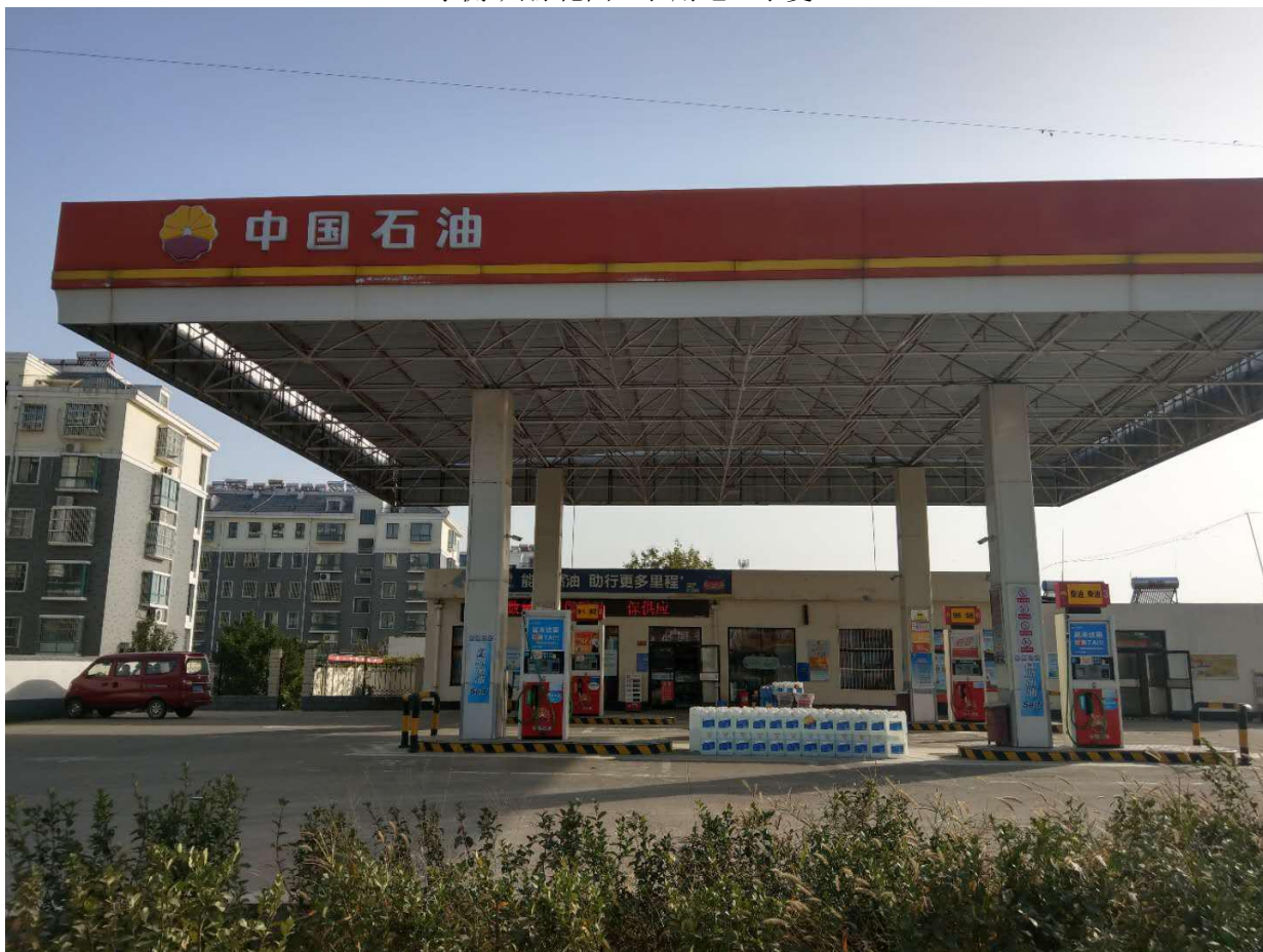
北侧-中国石油(泰安第 38 加油站)
