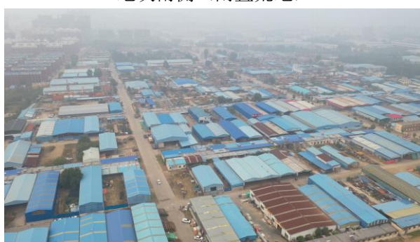
地块东侧（山东岱岳建材市场）
